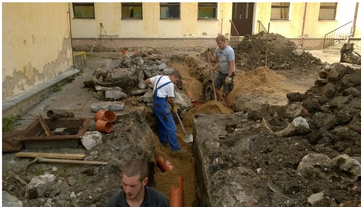
Během letních prázdnin byla opravena poškozená kanalizace ve dvoře mezi školními budovami.
